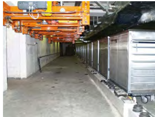
Abb. 5.13.8 Zwischenlager einer automatischen Versorgungsanlage. Die Wagen werden zur Ver- und Entsorgung eingesetzt
