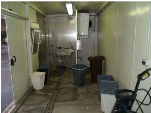
Abb. 5.10.5 Container zur desinfizierenden Reinigung von Glassammel- und Transportbehältern, mit Warmwasserversorgung und Desinfektionsmitteldosiergerät
