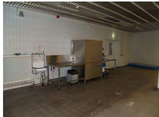
Abb. 5.10.6 Reinigungs- und Desinfektionsgerät für Glassammel- und Transportbehälter
