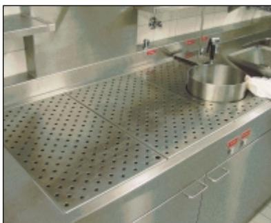
Entsorgen der Asservate: von links nach rechts: abgesaugte Abstellfläche, in die Absaugung integrierte Abgießöffnung für Formalin, abgesaugte Abwurföffnung
