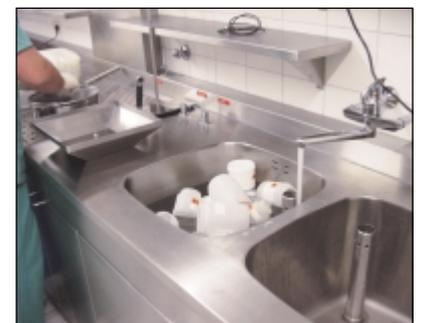
Entsorgen der Asservate: von links nach rechts: Abgießöffnung für Formalin, abgesaugte Abwurföffnung, Spülbecken
