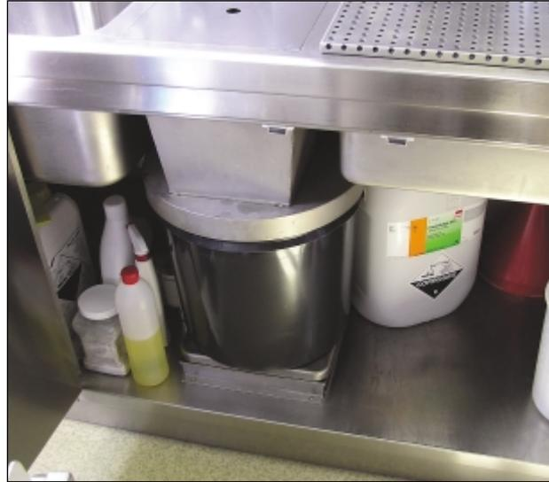
Entsorgung der Asservate: Eingelassenes Abwurfsieb mit Absaugung (links) und Abwurfschacht mit Abfallwaage (rechts)
