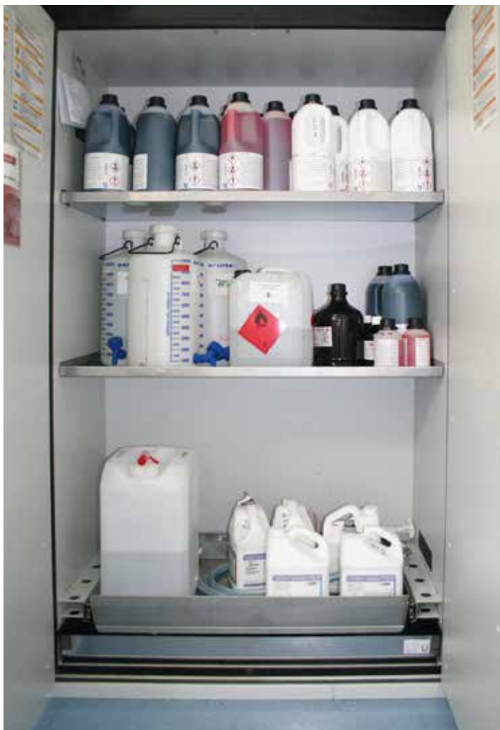
Sicherheitsschrank zur Lagerung von Gefahrstoffen
