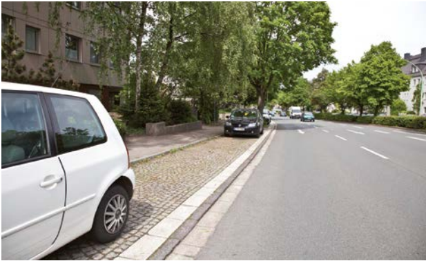
Auf dem gut einsehbaren Parkstreifen an einer innerörtlichen Hauptverkehrsstraße (zweispurig) ist ein sicheres Ein- und Aussteigen der Fahrgäste möglich.
